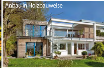
Anbau in Holzbauweise
