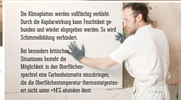
Die Klimaplatten werden vollflächig verklebt. Durch die Kapillarwirkung kann Feuchtigkeit gebunden und wieder abgegeben werden. So wird Schimmelbildung verhindert.
