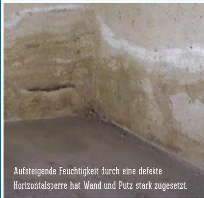
Aufsteigende Feuchtigkeit durch eine defekte Horizontalsperre hat Wand und Putz stark zugesetzt.
