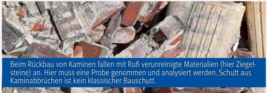
Beim Rückbau von Kaminen fallen mit Ruß verunreinigte Materialien (hier Ziegelsteine) an. Hier muss eine Probe genommen und analysiert werden. Schutt aus Kaminabbrüchen ist kein klassischer Bauschutt.
